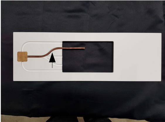
10. Anschlussrohr in die Gewünschte Nut einbringen
