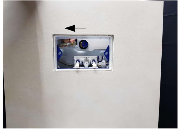
3. Verbindung zum Schwimmerventil
